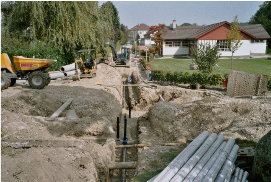
Wasserleitung Jurastrasse – Schulhaustrasse
