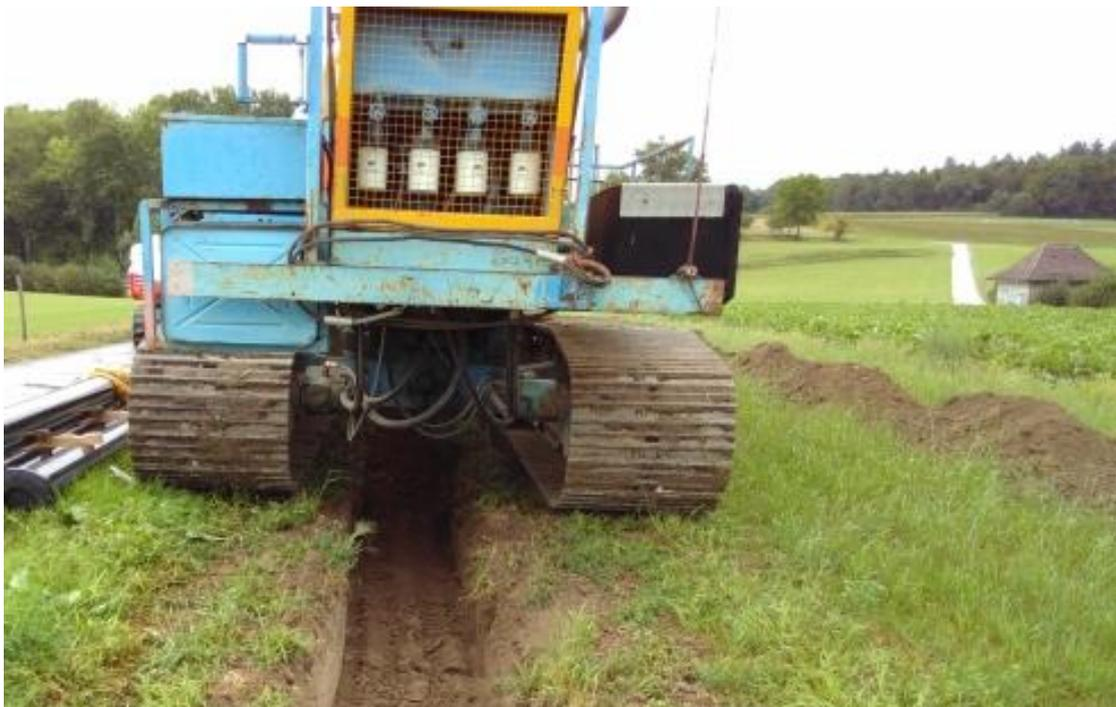
**Abbildung 5 Leitungsverlegung mittels Grabenfräse direkt auf dem gewachsenen Terrain mit vorgängig abgetragenen Oberboden (witterungsabhängig). Foto RSW AG.**
