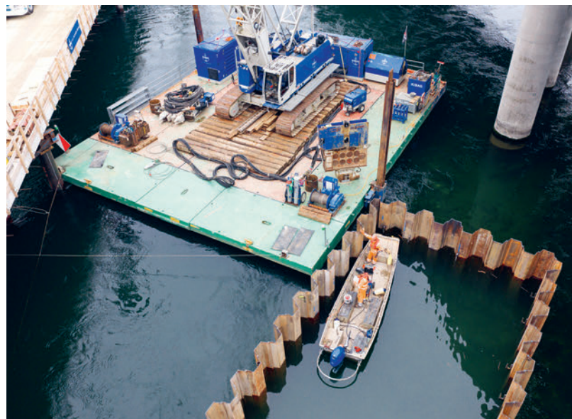
Bei der Arbeit in Wassernähe gehören Schwimmwesten und Rettungsboote zur Ausrüstung dazu.
