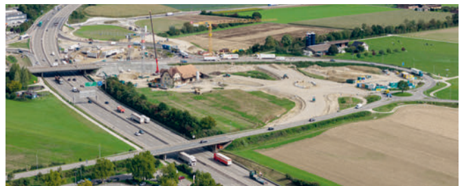
Umgestaltung des Autobahnanschlusses Egerkingen.
