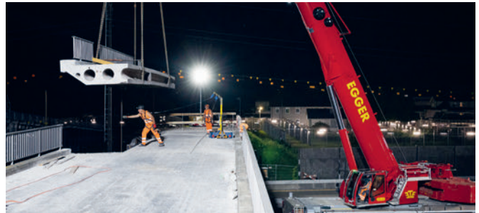
Abbruch der Schachenbrücke.
