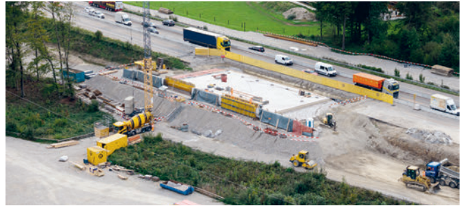
Bau der Wildtierunterführung bei der Aarebrücke.
