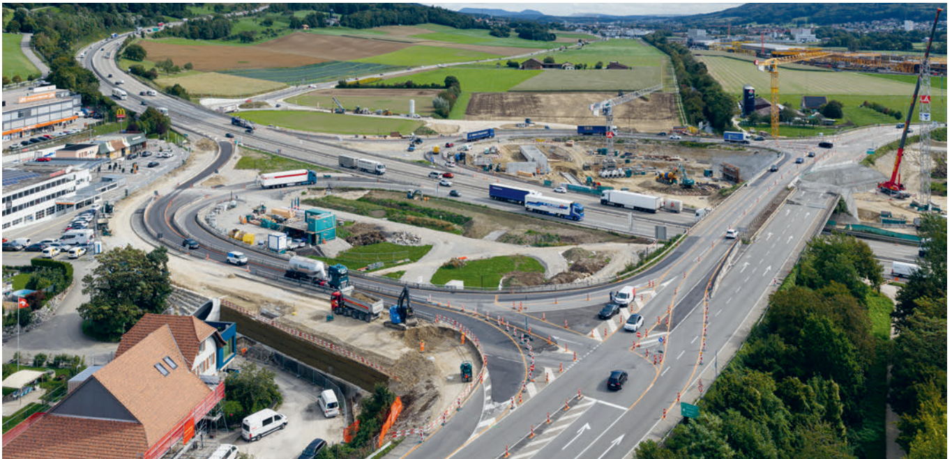
Die Herausforderung: Neubau bei laufendem Verkehr.
