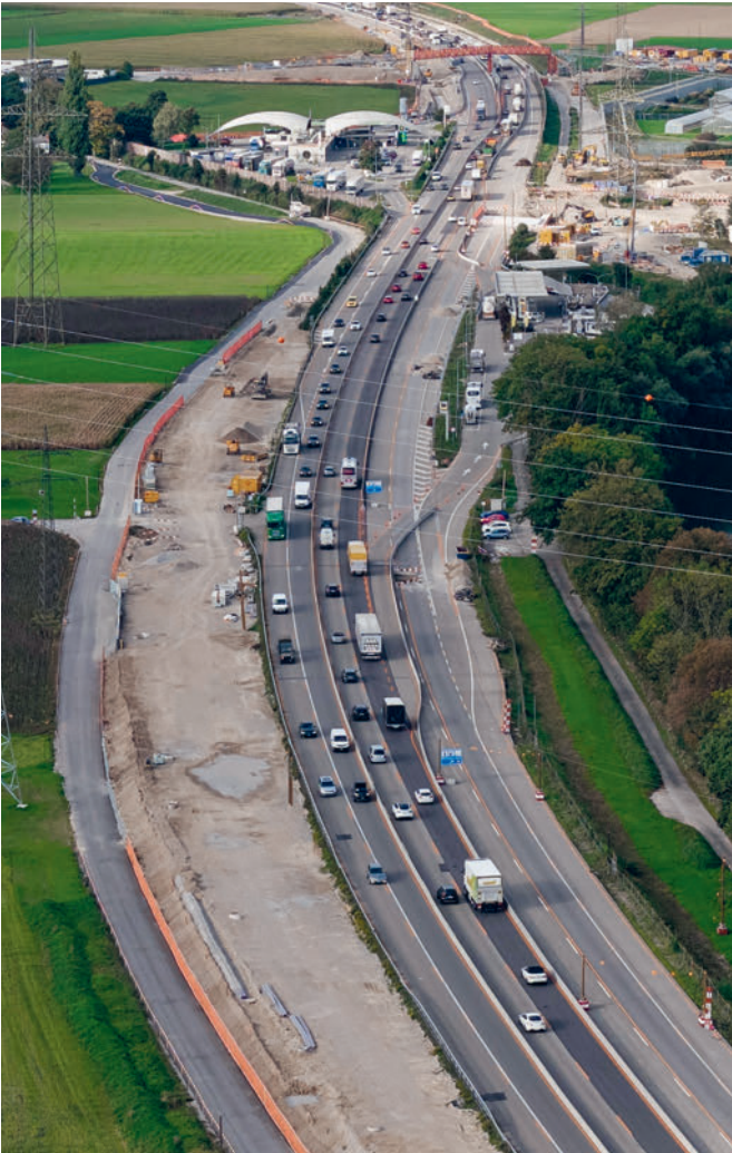
Arbeiten an der Fahrspur in Deitingen.
