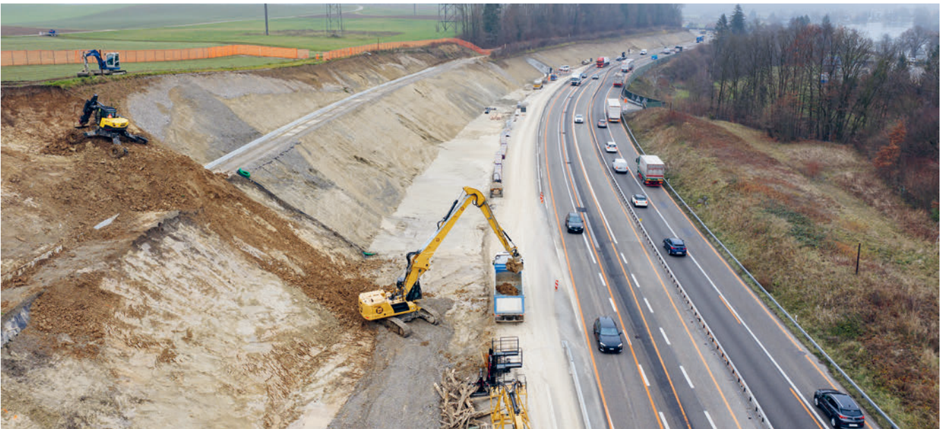
Geländeanpassung entlang der A1 für den Anschluss an die neue Aarebrücke.
